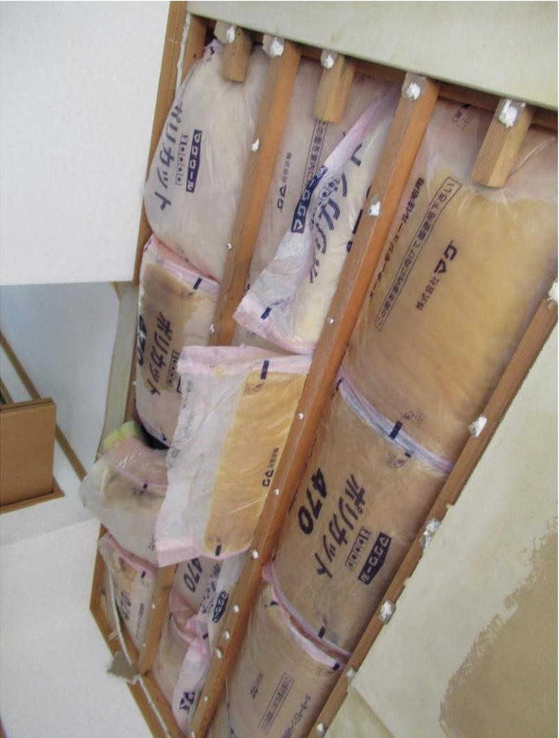
写真⑤ 家屋③ 2階天井 断熱材に水が浸み込み、26日に天井を突き破り、27日も水が滴り続いていた
