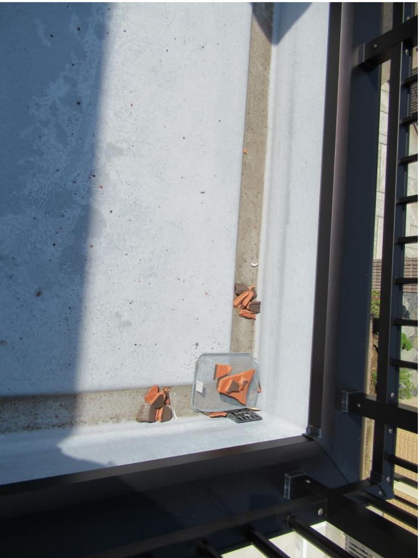
写真② 家屋② 2階ベランダ たまった水が排水しきれず天井に流れ込んだ
