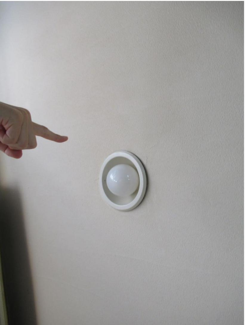
写真④ 家屋②別棟 1階天井 雨水があふれた照明と天井の隙間
