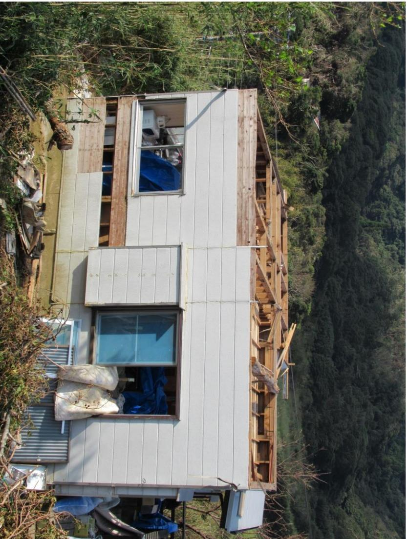
写真① 家屋① 屋根が飛ばされている
