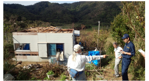
千葉県館山市で被災家屋を調査
