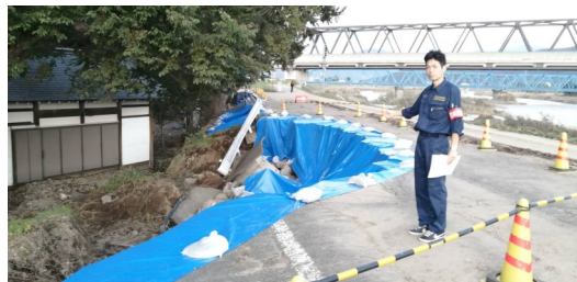
決壊寸前だった千曲川の堤防
