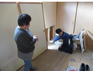
床上浸水のお宅を調査
