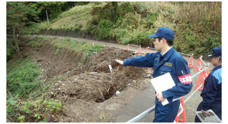
新潟県妙高市の道路崩落現場を調査
