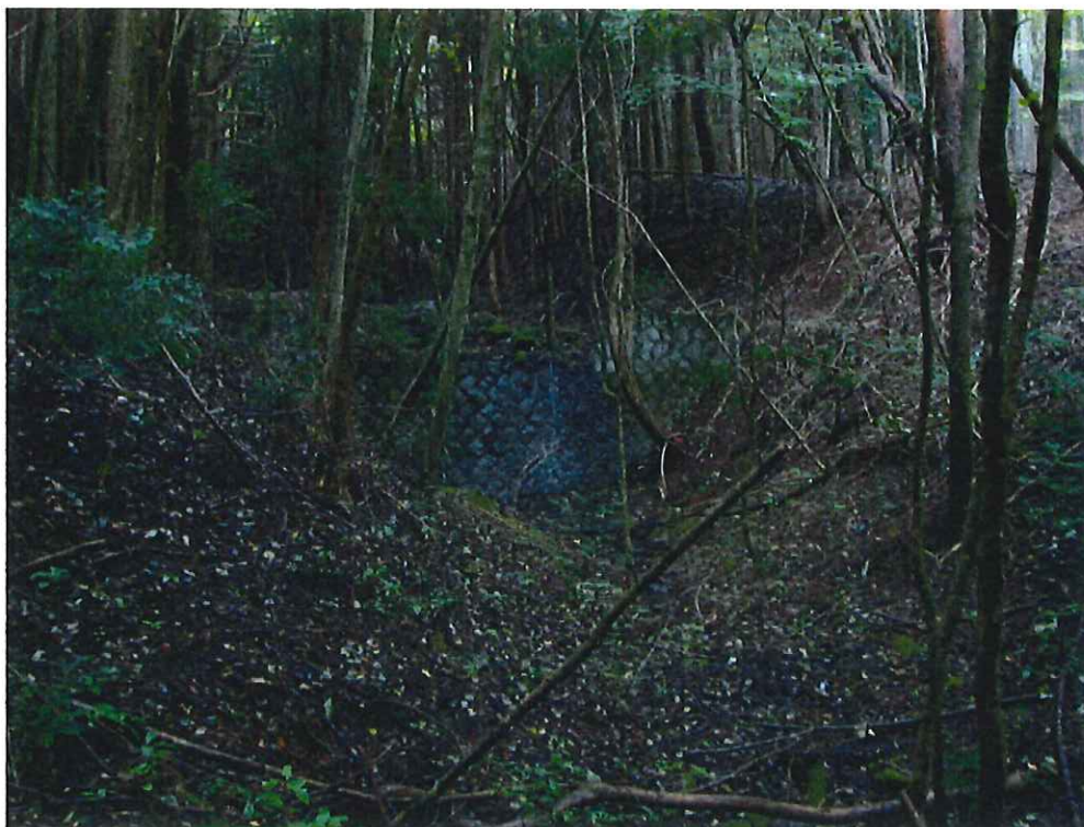
水が流れなくなった橋の上流部の沢（山梨県大月市笹子）
