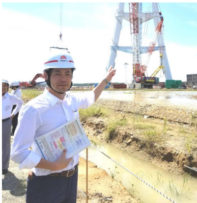
愛知県の中部電力武豊火力発電所調査
