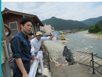
岐阜 豪雨被害調査
