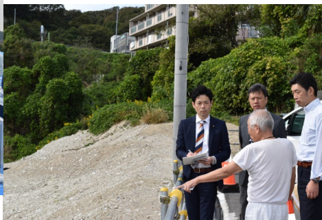
兵庫でメガソーラー崩落現場を調査
