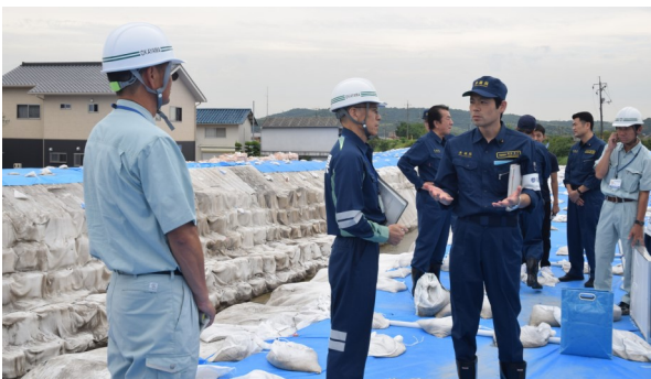
岡山県倉敷市真備町の豪雨災害現場などを 参院災害対策特別委員会で視察
