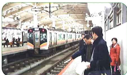
新潟駅2番線ホームの転落現場を調査(2月)
