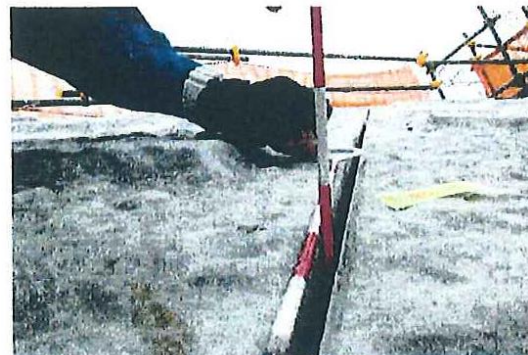
法覆大型ブロックの目開き
